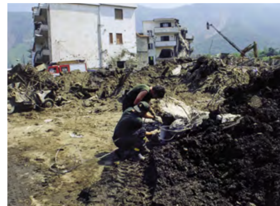
Foto 41. La frana di Sarno del maggio 1998.
