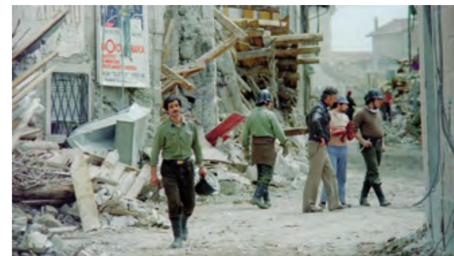
Foto 28. Squadre di soccorritori all'opera in seguito al terremoto in Friuli del 6 maggio 1976.
