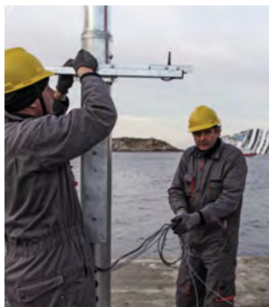
Foto 123. Isola del Giglio, Toscana, 2012. Tecnici al lavoro nell'area del naufragio della nave da crociera Costa Concordia.
